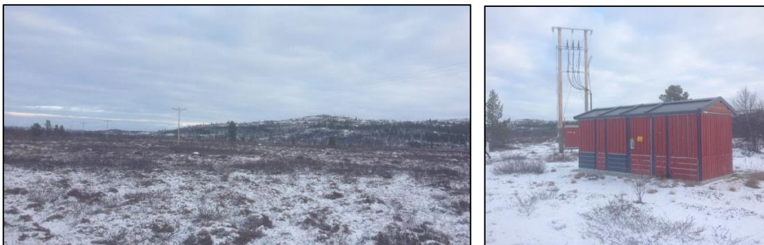
Figur 22: Høyspentledning langs varslingsområdet. Trafostasjon nær finskegrensen.
