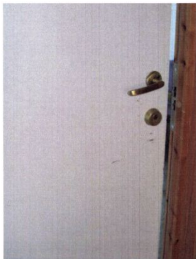
Bilde nr 27 og 28 viser vanlig slitasje på typisk innerdør.
