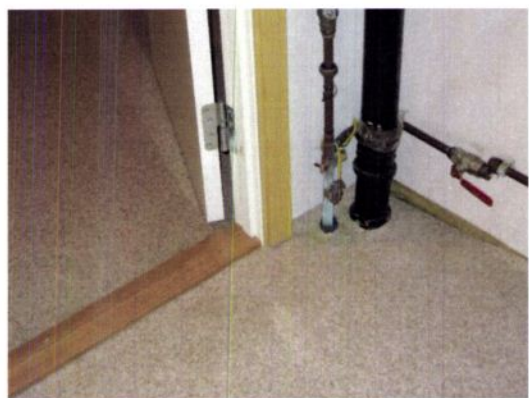
Bilde nr 11 og 12 viser rørgjennomføring i henholdsvis våtrom og rehabilitert våtrom.
