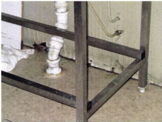
Bilde nr 17 viser vannskade på felleskjøkken.
