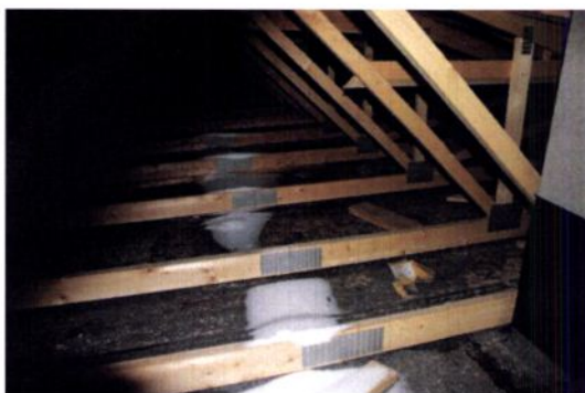
Bilde nr 23 viser innfyk på kaldloft.
