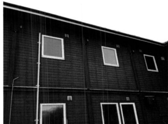
Bilde nr 37 viser utvendig fordeling mellom moduler.
