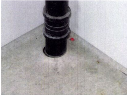
Bilde nr 11 og 12 viser rørgjennomføring i henholdsvis våtrom og rehabilitert våtrom.
