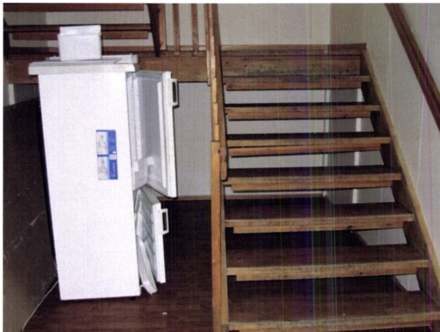
Bilde nr 33 viser trapp mellom etasjene.
