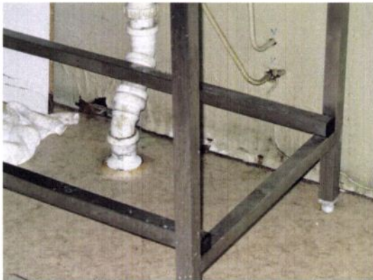
Bilde nr 17 viser vannskade på felleskjøkken.
