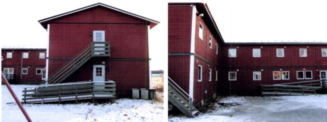
Bilde nr 2 og 3 viser utvendige trapper og plattinger.
