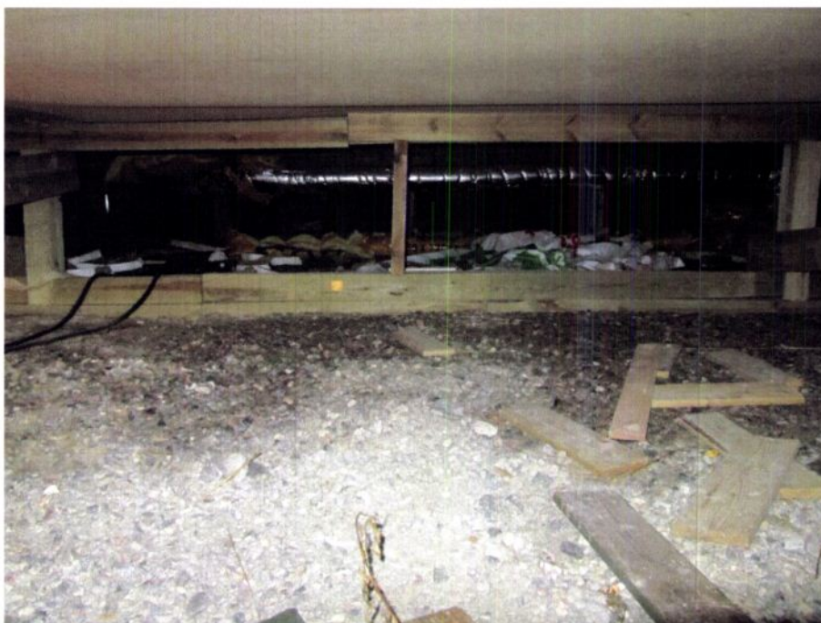
Bilde nr 1 viser fundamentering av bygget.
