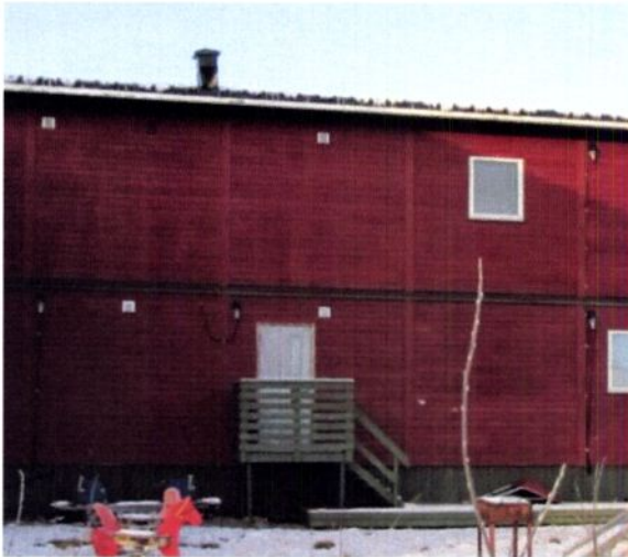
Bilde nr 4 viser utvendig panel samt utvendig dør og trapp.
