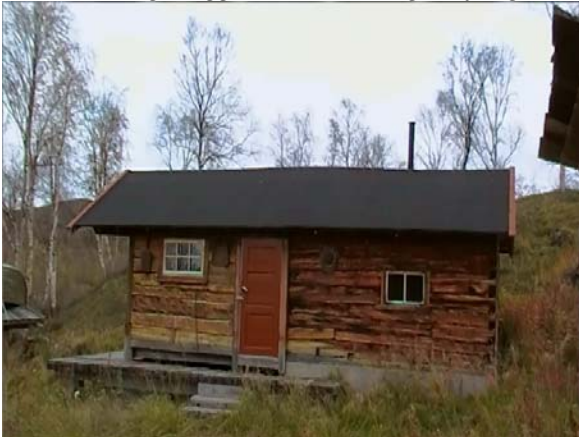
Lafta bygning som er ombygd til badstu
