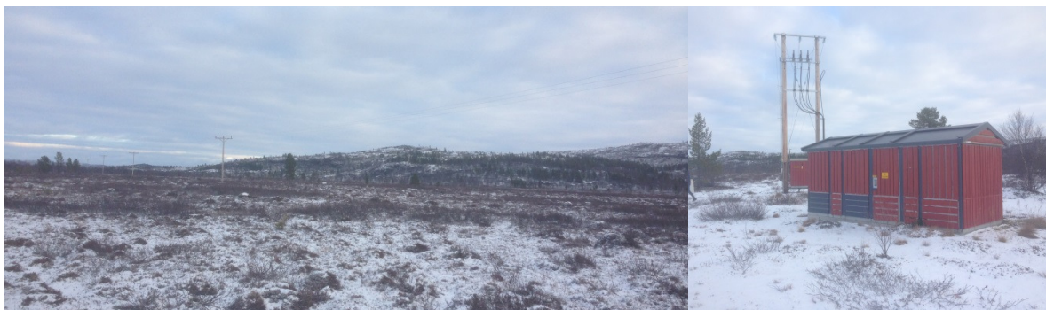
Figur 19 Høyspentledning langs varslingsområdet. Trafostasjon nær finskegrensen
