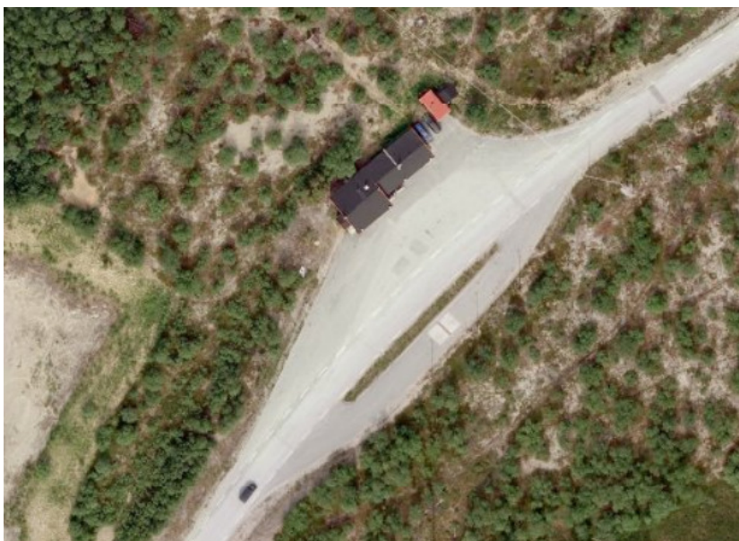
Figur 17 Veiløsning ved eksisterende tollstasjon. Skuterløype kan skimtes i høyre kant av bildet
