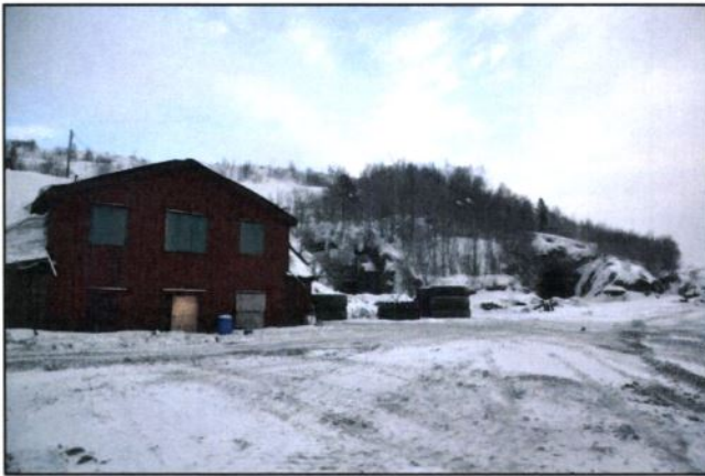
Figur 9 - Rørbua med badetunellen og 1944-tunellen,
