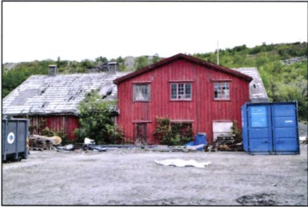
Figur 5 - Rørbua mot sør, juni 2013
