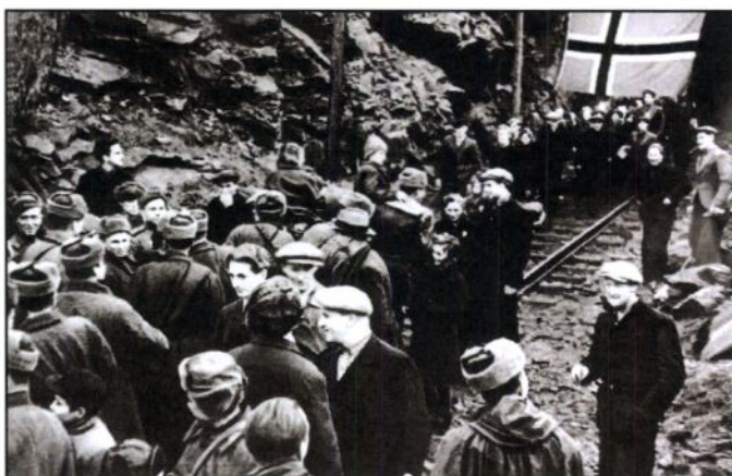
Figur 11 og 12: Bilder av frigjøringen og utgang i fra tunnelen. Kilde: Finnmarksbiblioteket
