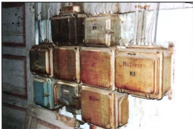
Detalj fra gang. Veggfast og en del av fredningen.
