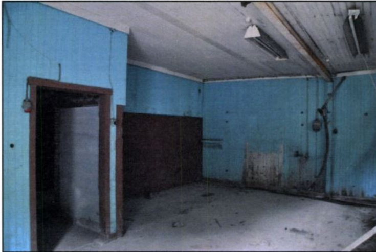
Bildene viser rommet mot nord. Gulvet er støpt i betong. Veggene delvis panelt og delvis støpt.
