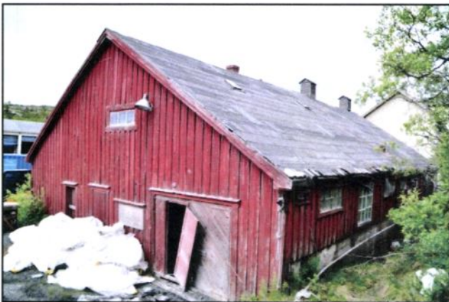
Figur 7 - Rørbua mot sør og øst, juni 2013
