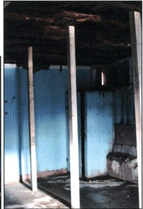
Bildene viser rommet mot nord. Gulvet er støpt i betong. Veggene delvis panelt og delvis støpt.
