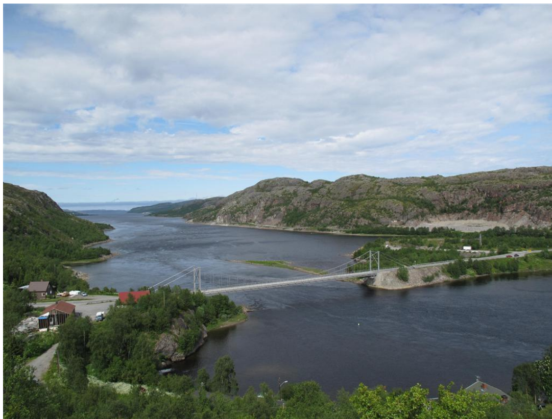
Figur 7: Elvenes bru. Hengebru fra 1960. Sett mot nordøst. Foto: Jørn Uno Mikkelsen, Statens vegvesen.
