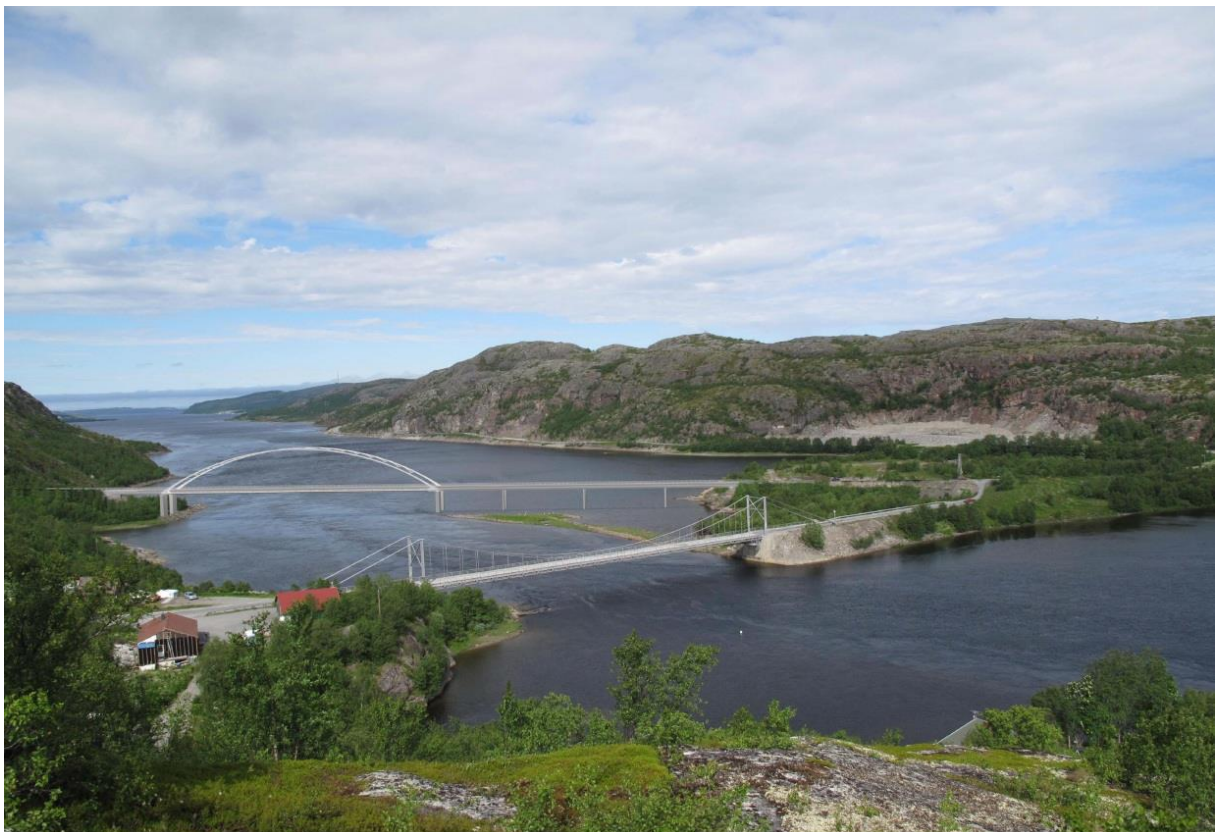
Figur 12 - Nettverksbuebru og viadukt. Bildet er tatt ved høyvann. Planlagt fylling er ikke tegnet inn. Fotomontasje: Statens vegvesen
