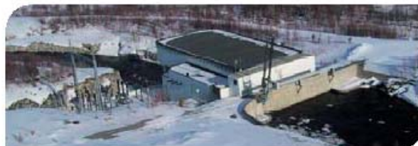
Melkefoss Kraftverk Elvekraftverk Årsmiddelproduksjon: 129 GWh Installert effekt: 1 x 26 MVA Ikke noe praktisk magasin
